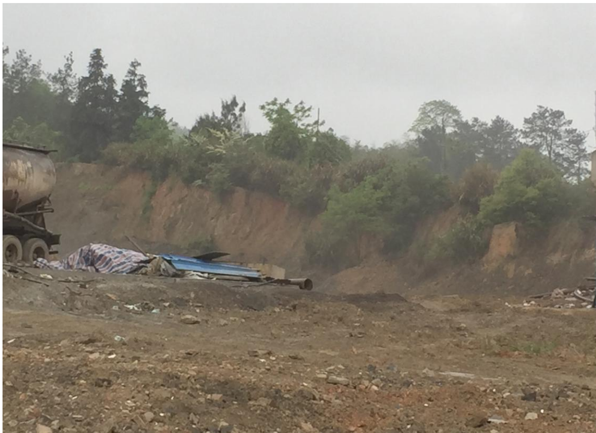
照片 3-2 QP5 现状
