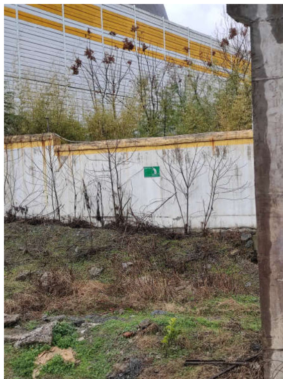
二期循环水排放口
