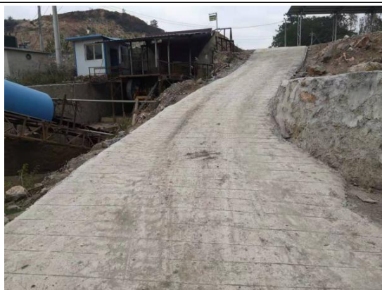
图3-6 厂区地面硬化
