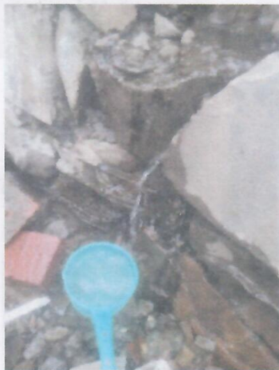
★1 生活废水总排口
