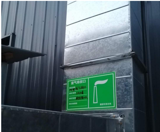
喷塑废气排口（DA001）标识
