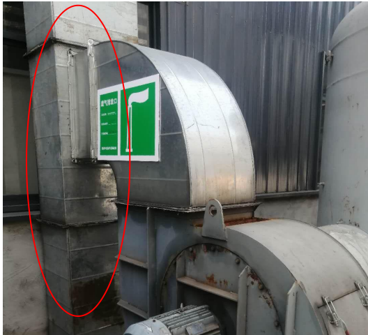
注塑废气收集管道
