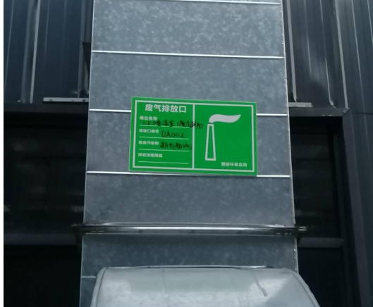
人工喷漆室 1 废气排口（DA002）标识
