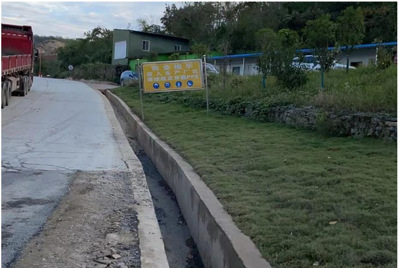
砖砌排水沟照片照片（2021年9月）
