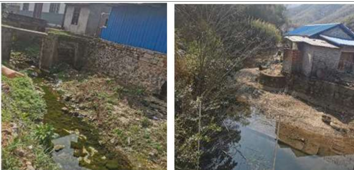
影响行洪建筑物照片
